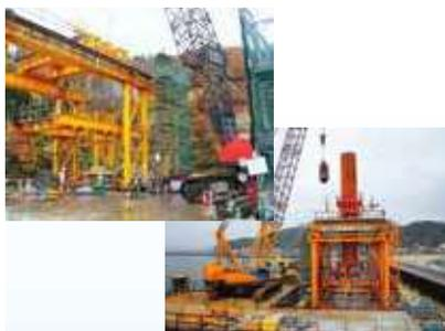
支持圧入式沈下装置は、PCウェルを懸
