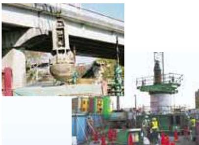
圧入式沈下装置は、PCウェル工法で使用
