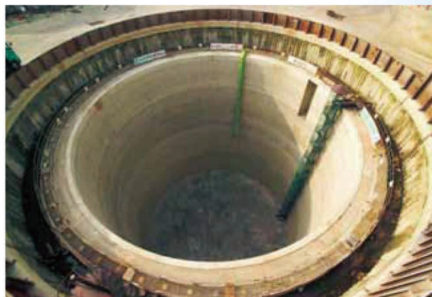
寺畑前川調節池 外径35.0m 深度46.0m
