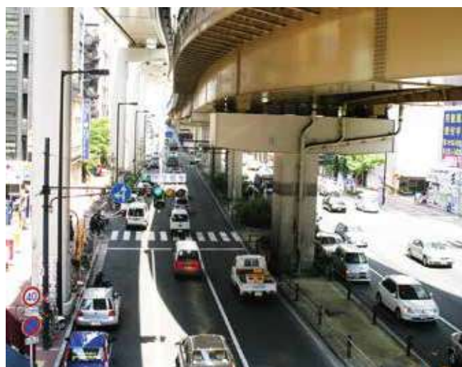
新御堂筋線梅新南ランプ 基礎(φ3.5m)
