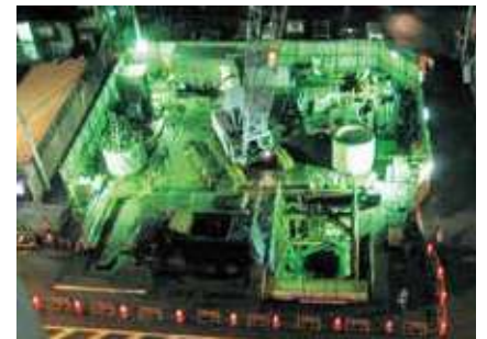
大森・蒲田共同溝工事
