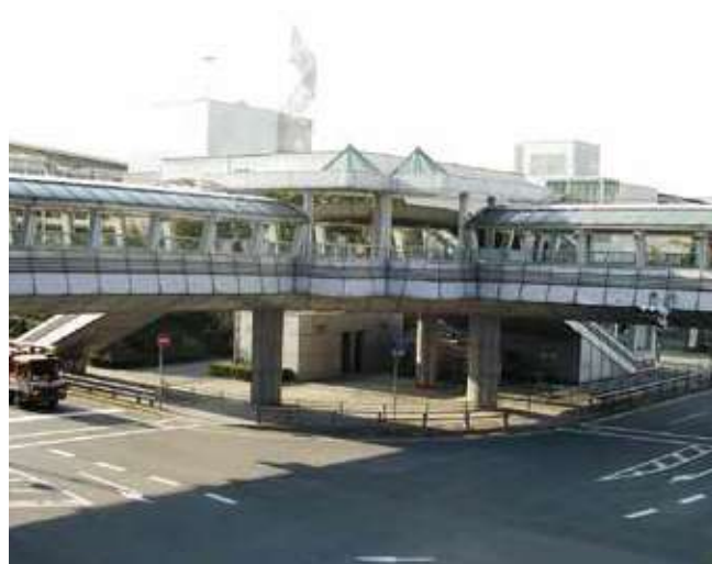
幕張A地区デッキ 基礎(φ2.0m)
