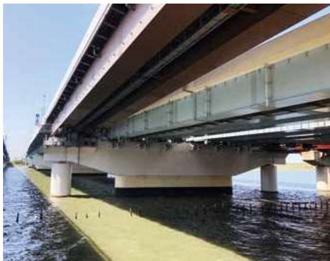
高谷JCT高架橋 橋脚・基礎(φ3.5m)
