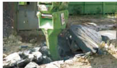
リッパーによる破碎状況
