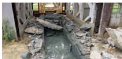
バケット(幅1m、0.55m)による掘削状況
