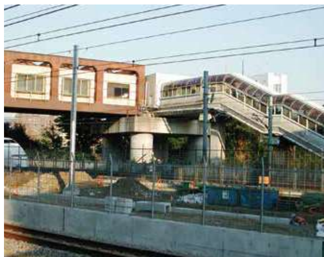
浜松町駅跨線橋 基礎(φ3.0m)
