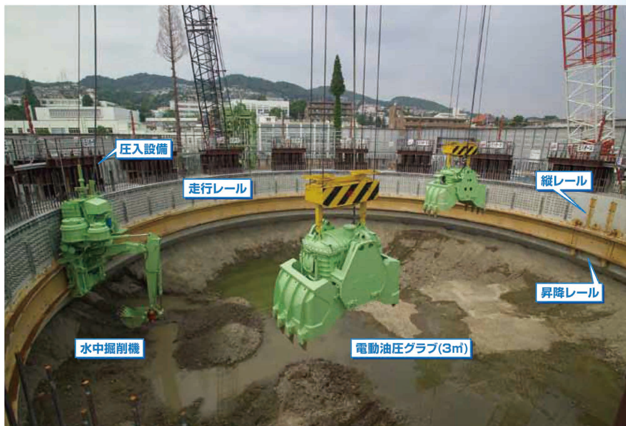
▲ ケーソン内の掘削 揚土状況
