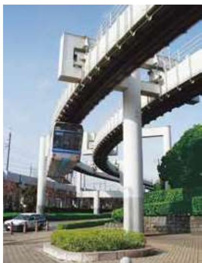
千葉モノレール 基礎(φ1.6~3.5m)
