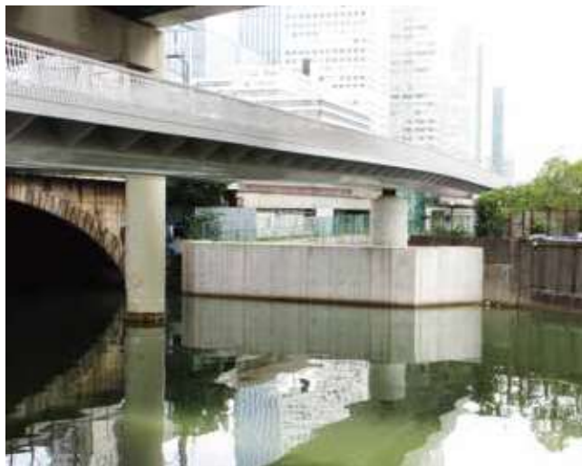
日本橋川橋梁 橋脚・基礎(φ2.5m)
