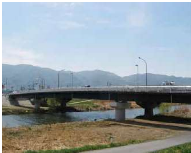
新六斗橋 橋脚・基礎(φ3.0m)
