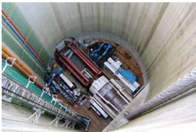
茨城立坑 外径23.4m 深度50.0m
