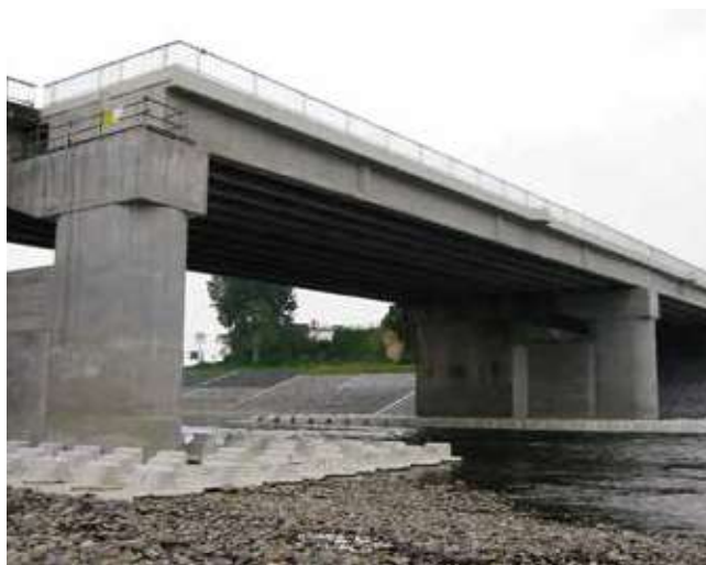
和田橋拡幅下部 橋脚・基礎(小判3.8m)
