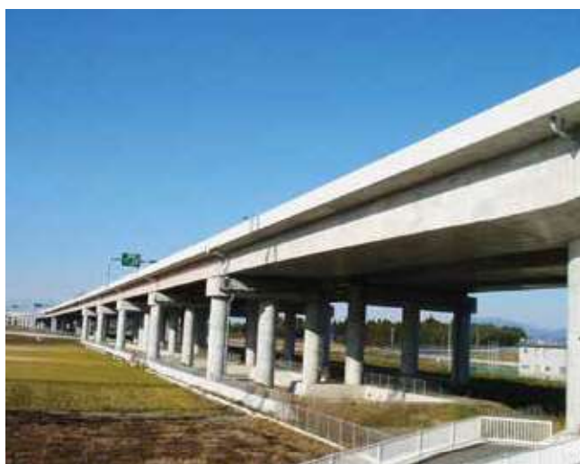
つくば高架橋 基礎(φ3.0m)
