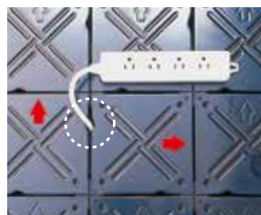
配線取出し口(パネルUカット部を使用) OAタップを取り出すときは、 パネルの矢印の向きを変えてください。
