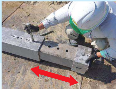
② 内腹起しを必要な長さまで引出し、接続ピンで固定します
