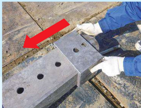
③ 内腹起し端部の外カバーを内側にスライドします
