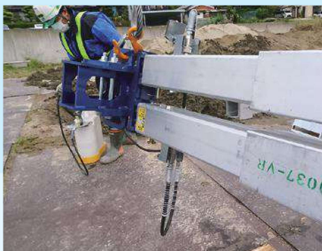
⑤ アタッチメントと水圧四面梁の接続時は、必ずカプラーが上下逆に向くように取付けてください
