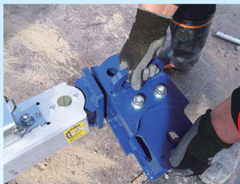
⑤ 水圧四面梁に、④で組立てたコーナー金具を組付けます
