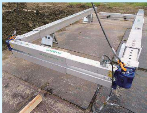
⑥ 水圧ハンドポンプで長さを調節しながら取り付けを行います 両サイドに取り付けたら完成です
