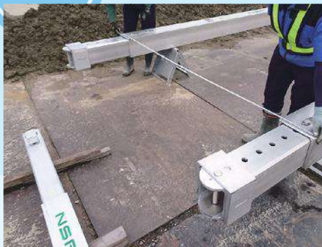
① 組立て時、四面梁4型と地面の間は40cm程度のクリアランスを確保してください
