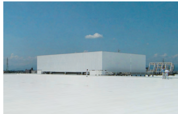
食品卸ビル屋上
