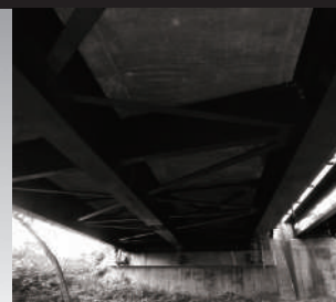
橋の床板に施工し塩害抑制
