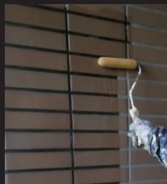
目地部を遮水して外壁タイルの浮き予防
