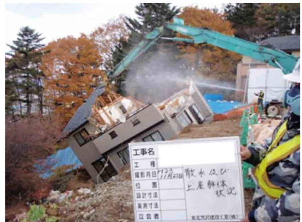
写真-2 損壊家屋の解体状況（仙台市青葉区 2011年11月22日）
