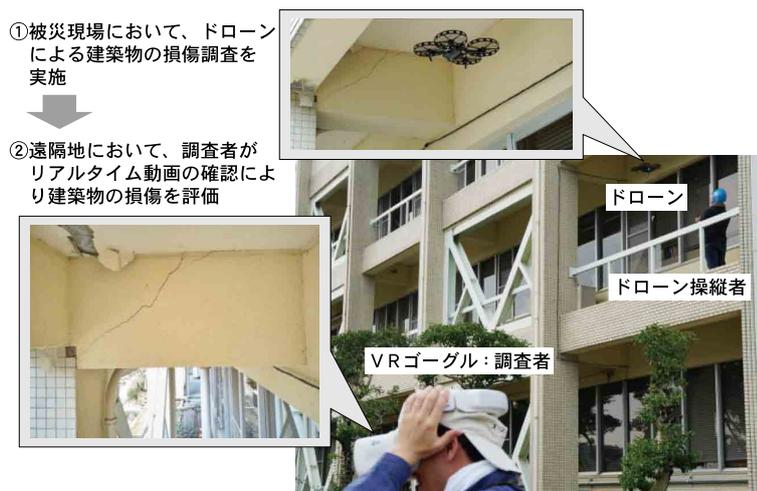
写真-5 遠隔地から被災建築物の損傷状況を確認・評価するためのドローンの活用
