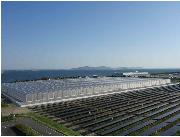
写真－1 次世代施設園芸愛知県拠点の全容（愛知県豊橋市）
