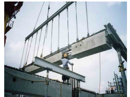
写真-1 プレキャスト工法(梁)の例
