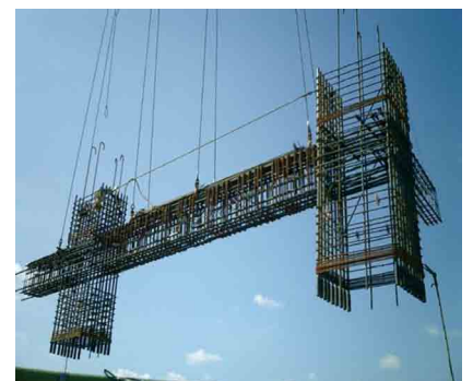
写真-3 鉄筋先組み工法の例
