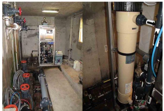
写真-2 新設された膜ろ過装置
