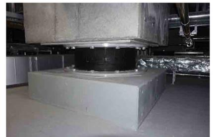
写真-2 免震層の積層ゴム設置状況
