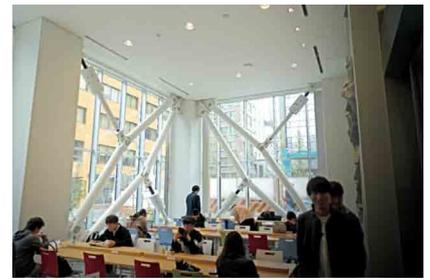
写真-1 D.M.ダンパーの設置状況
