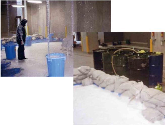
写真-3 泡消火設備の泡放射試験
