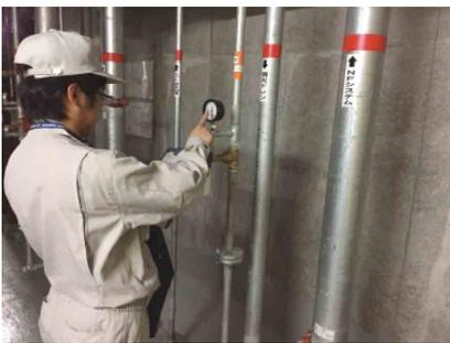
写真-4 末端試験弁廻りの点検
