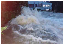
・ 漏水による道路冠水
