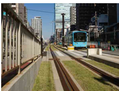
写真-4 阪堺上町線軌道敷の芝生化
