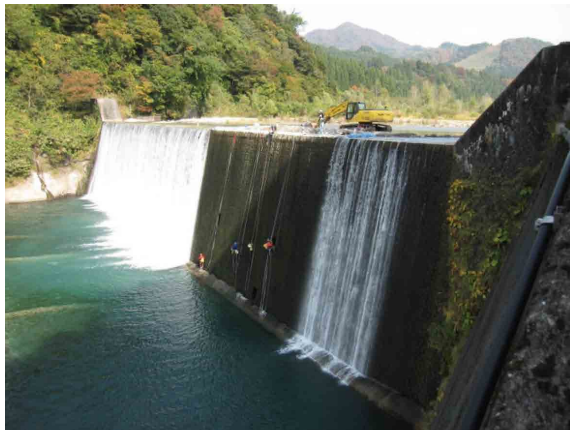
写真－２ 大規模砂防堰堤における詳細外観調査の例
