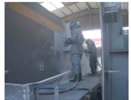
写真-2 溶線式ガスフレーム溶射法による防食溶射現場
