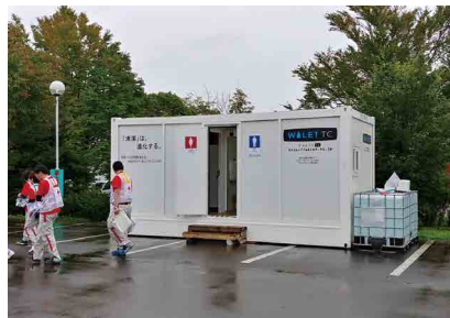
写真－6 避難所に設置されたコンテナ型の仮設トイレ（北海道胆振東部地震）
