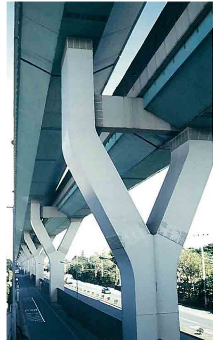
写真-7 辰巳高架橋 (Y字橋脚)
