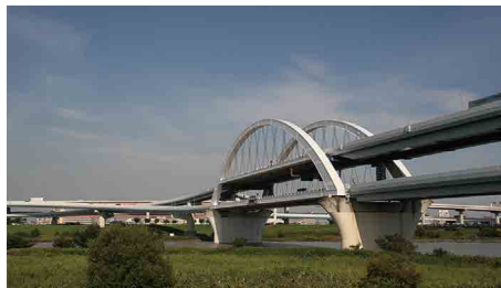
写真-12 五色桜大橋
