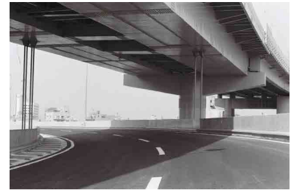
写真-3 両国ジャンクションの吊下げ構造
