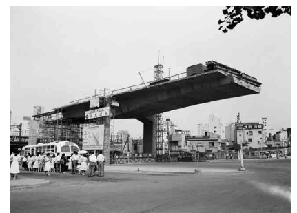
写真-5 渋谷高架橋（ディピダグ工法）
