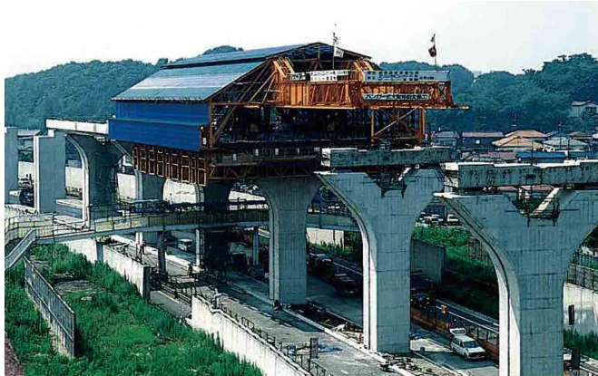
写真-8 高島平高架橋 (SSM式移動吊支保工)
