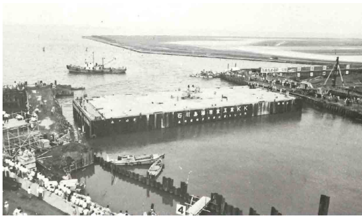
写真-14 羽田トンネルの沈埋函
