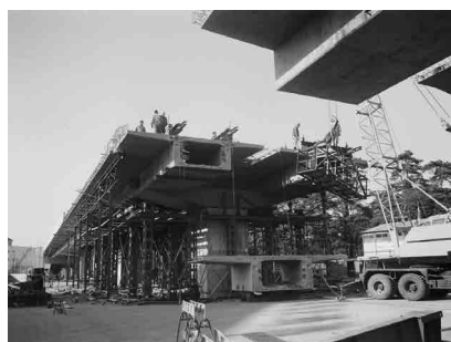
写真-4 目黒架道橋（プレキャストブロック）
