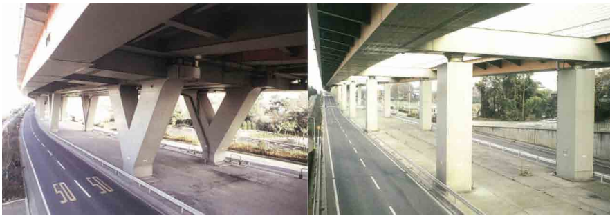
写真-6 V橋脚立体ラーメン橋・多径間連続鋼箱桁橋
