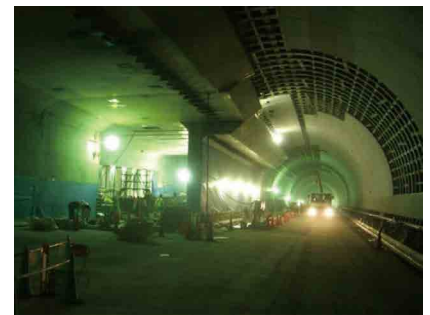
写真-15 シールドトンネル切開き
