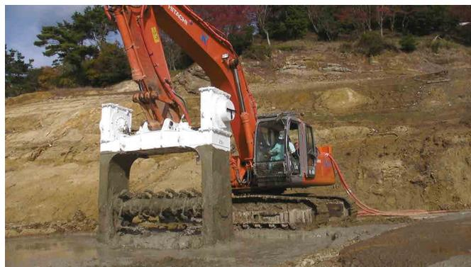
写真-2 攪拌混合機 (DAM機) による初期固化工程
