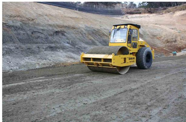
写真-4 振動ローラによる築堤工程
