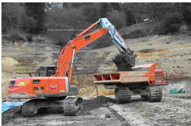
写真-3 バケット式解砕機による解砕工程
