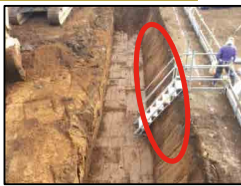
オープンカット法面整形(60' 3D)
