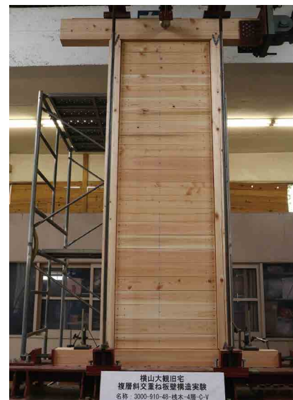
写真-1 載荷装置と試験体設置状況
