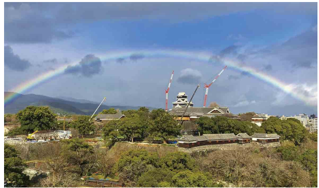
写真－２ 復旧がすすむ熊本城
