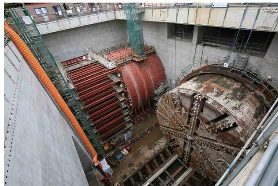
写真-2 シールドマシン到達状況 (2018年9月)
