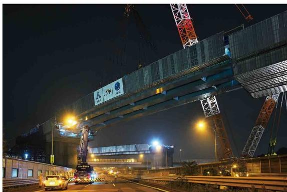
写真-1 東名高速本線交差部における桁架設 (2017年10月)
