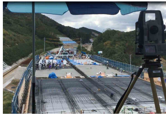
図-10 TSIによる床版打設の品質管理 3)
