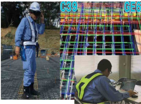
図-7 現場と事務所の配筋遠隔検査 3)
