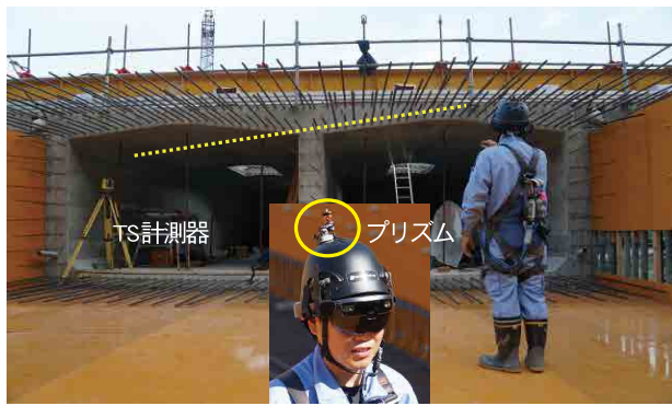
図-12 MRとTSの連携による計測
