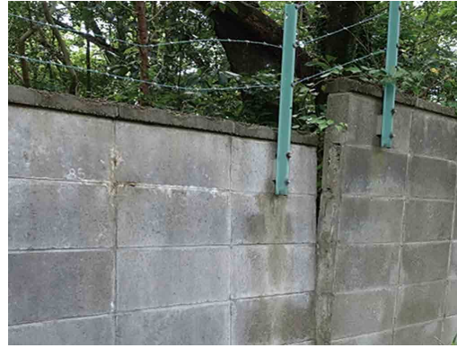
写真-2 塀の傾き
