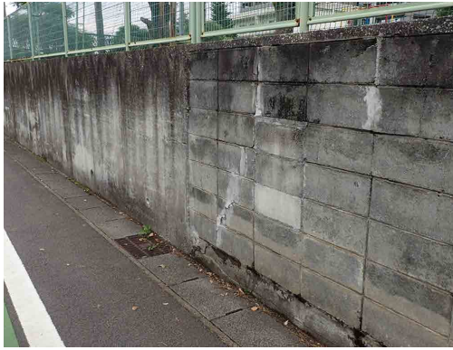
写真-1 塀のひび割れ
