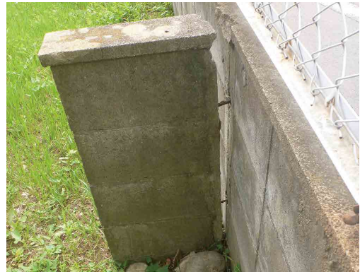
写真-4 控え壁の損傷
