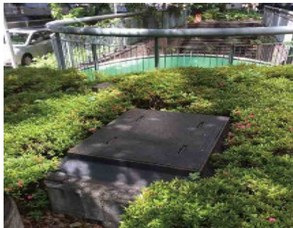
写真-5 大型メータボックス
