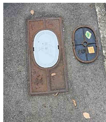
写真-2 通信環境改善対策(蓋を鉄製から樹脂製に変更)
