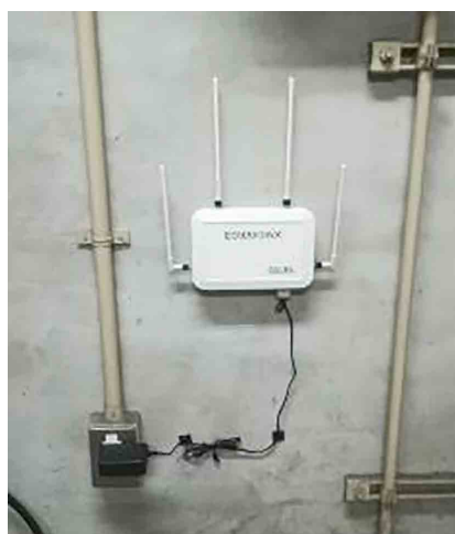
写真-1 通信環境改善対策(中継器設置)
