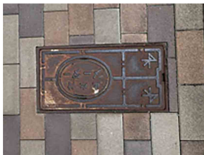
写真-4 鋳鉄製メータボックス
