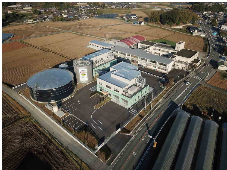
写真-1 みやま市バイオマスセンター「ルフラン」
