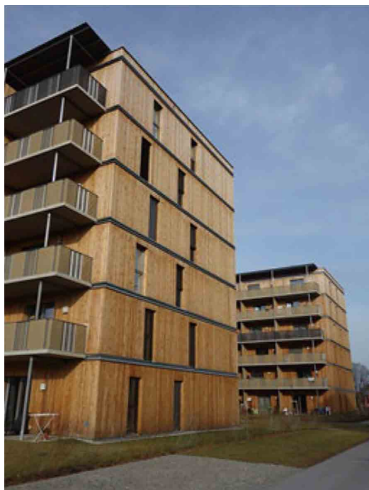
写真-1 オーストリアのゼロエネ6階建て木造CLT（提交材）集合住宅
