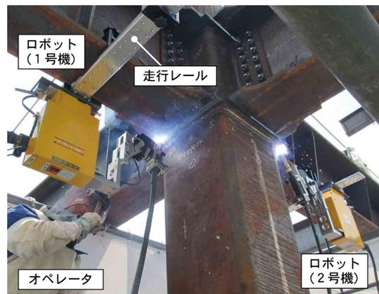
写真-1 梁下フランジの上向きロボット溶接状況
