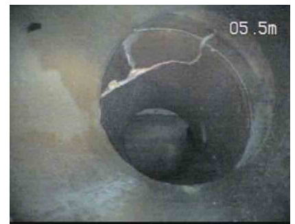
写真-3 取付管のクラック
