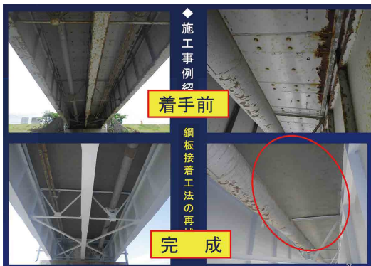
図-11 鮭川橋（山形県最上総合支庁）H28年2月
