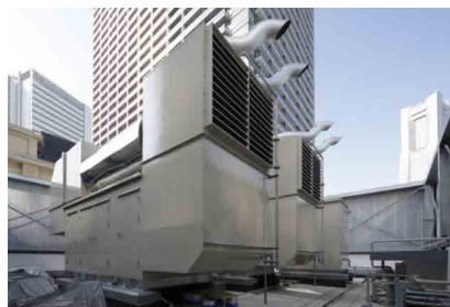
写真-7 塀の内側に設置された非常用発電設備
