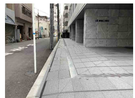
写真-3 建物1階床面の嵩上げ①
