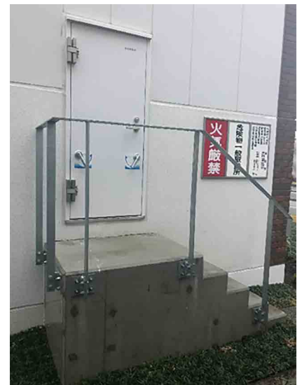
写真-8 塀に設けた防水扉
