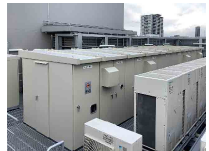
写真-2 屋上の高圧受変電設備
