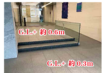
写真-4 建物1階床面の嵩上げ②
