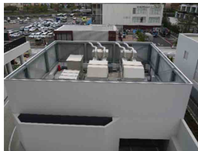
写真-6 非常用発電設備の見下ろし
