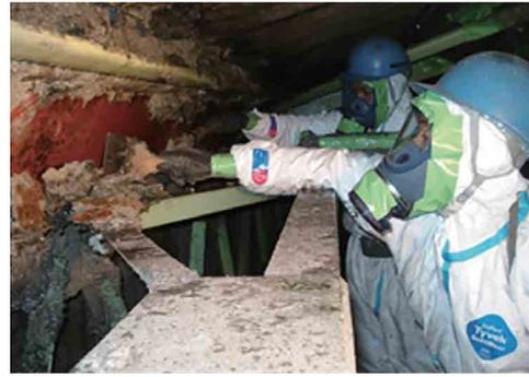
写真一 6 吹付け石綿の除去作業の様子
