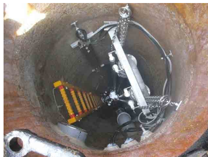
写真-4 ①取水ポンプ内
