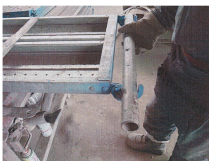
写真-2 床付き布わくのつかみ金具の変形 の有無の確認（選別作業）
