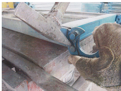
写真-4 床付き布わくのつかみ金具の外れ 止めの修理（修理作業）
