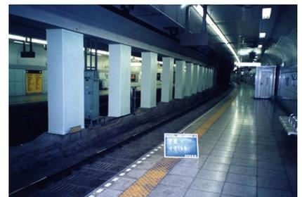
写真-3 トンネル中柱の補強
