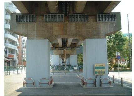
写真-1 高架橋柱の補強
