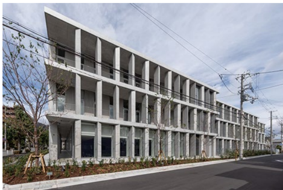
図-3 建物外観写真
