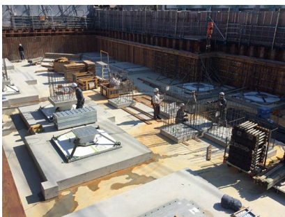
写真-4 免震材料施工写真1
