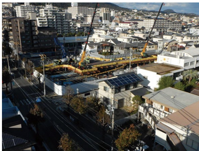
写真-3 全景施工写真
