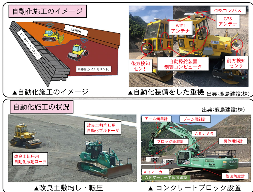
図-12 災害復旧現場における自動化施工
