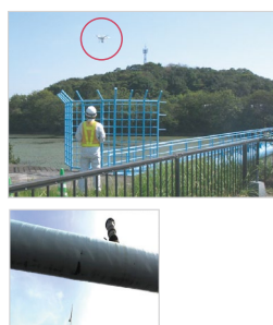
図－７ 福岡県北九州市 水管橋の点検におけるドローン（小型無人航空機）の導入
