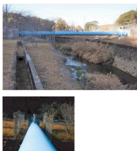
図－７ 福岡県北九州市 水管橋の点検におけるドローン（小型無人航空機）の導入
