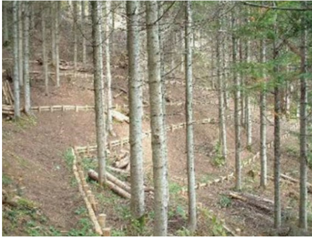
写真－7 森林整備と筋工等の組合せ施工事例（北海道）
