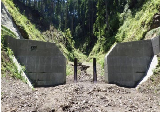
写真－3 流木捕捉式治山ダムの施工事例（福岡県）
