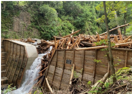
写真－4 国土強靱化3か年対策で整備した流木捕捉式山ダムが令和2年7月豪雨で流木を捕捉した状況（熊本県）
