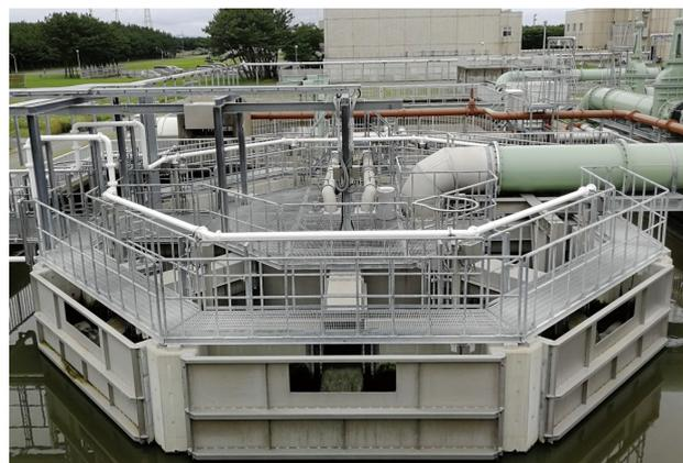
写真-1 超高効率固液分離装置
