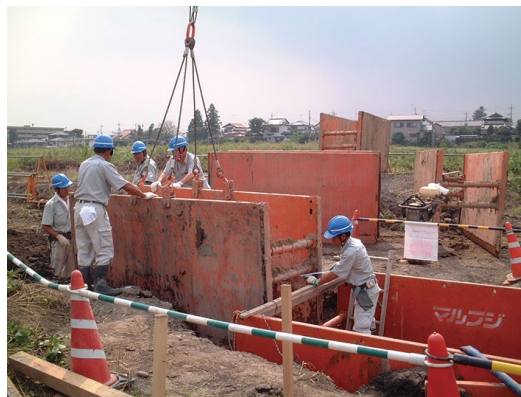
写真－７ 縦梁方式の吊上げ作業
