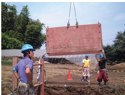
写真－６ スライドレール方式のパネルの吊上げ作業
