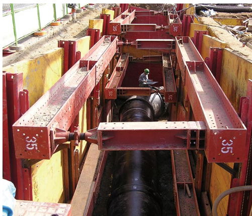
写真－８ 腹起し作業（ピットの作成）
