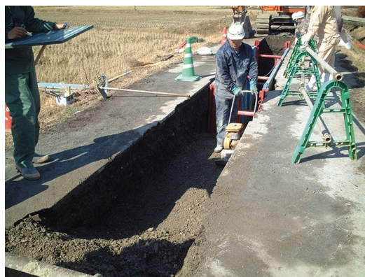
写真－５ 埋戻し・締固め（転圧）作業手順
