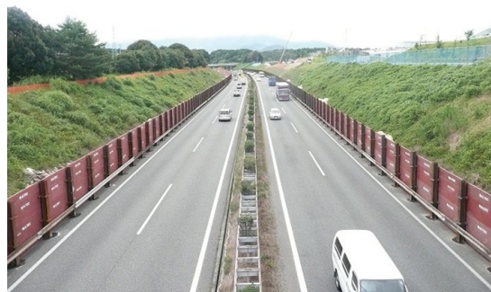
写真－11 道路の防護柵（落石対策）
