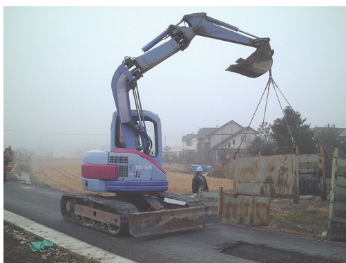
写真－４ 縦梁方式は４点吊（重量確認）
