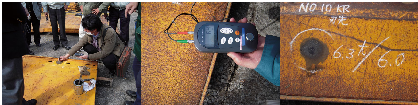
写真－3 経年機材の点検作業：鋼材の厚み測定現場（各会員が自主点検を行う）
