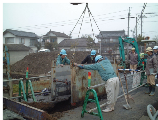
写真－2 縦ばりプレート方式
