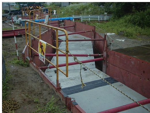
写真－９ カルバート設置作業
