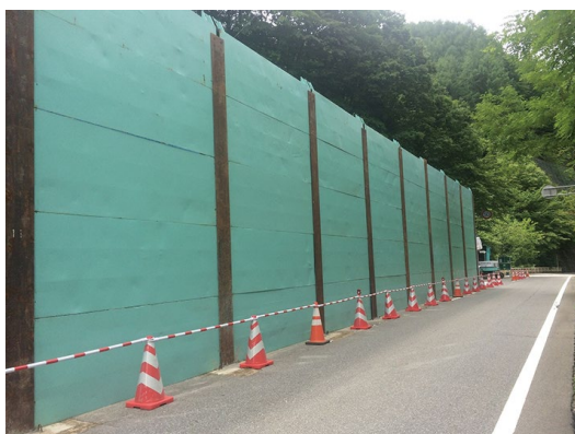
写真－11 道路の防護柵（落石対策）
