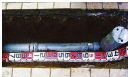
図－9 衝撃に強い硬質塩化ビニル管への取替え
