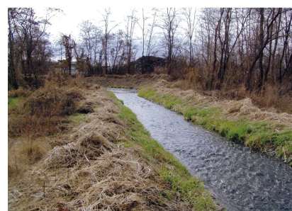
写真－２ 旧水路_開削部
