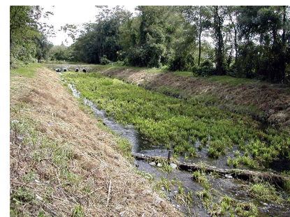
写真－６ 新水路_開渠
