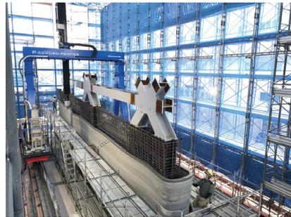
写真-6 ガントリー型プリンタによるオンサイトプリンティング
