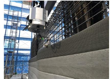
写真-7 組み立てた鉄筋の外周へのプリンティング
