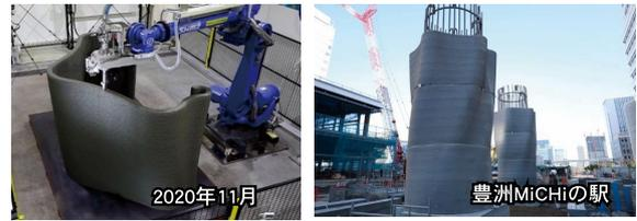
現場適用部材と同一の製造方法/養生条件
