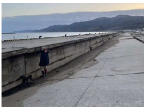
写真－1 重力式係船岸（左：輪島港，右：飯田港）の被災状況
