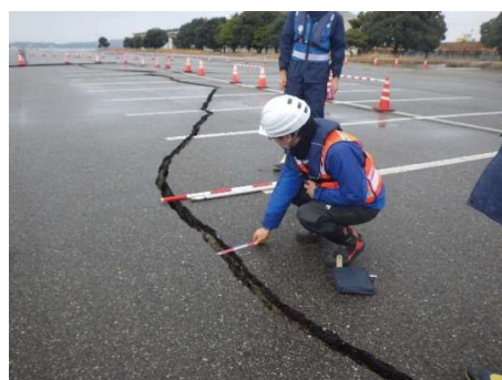
写真－2 栈橋（七尾港）の被災状況
