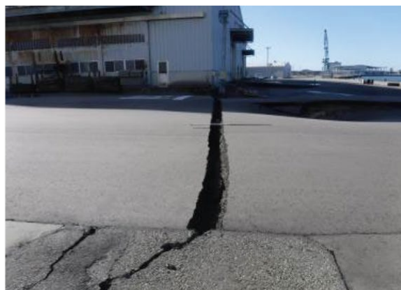
写真－3 矢板式係船岸（金沢港）の被災状況
