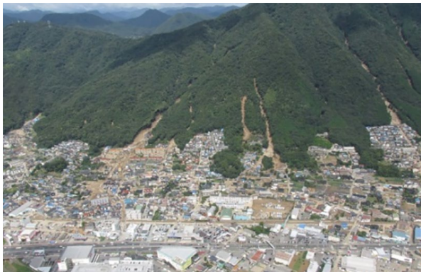
写真-2 安佐南区八木・緑井地区の被災状況
