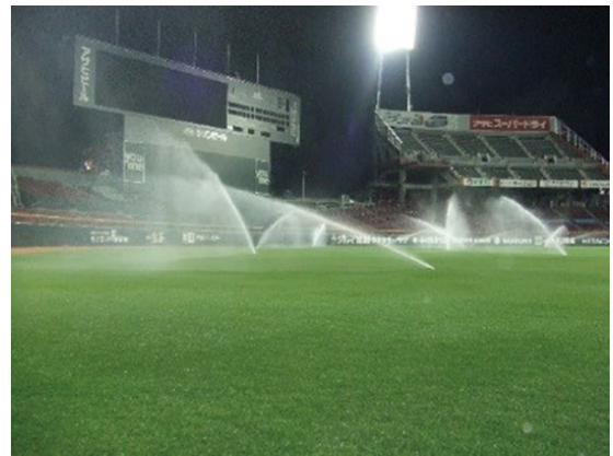
写真-4 天然芝グラウンドへの散水状況
